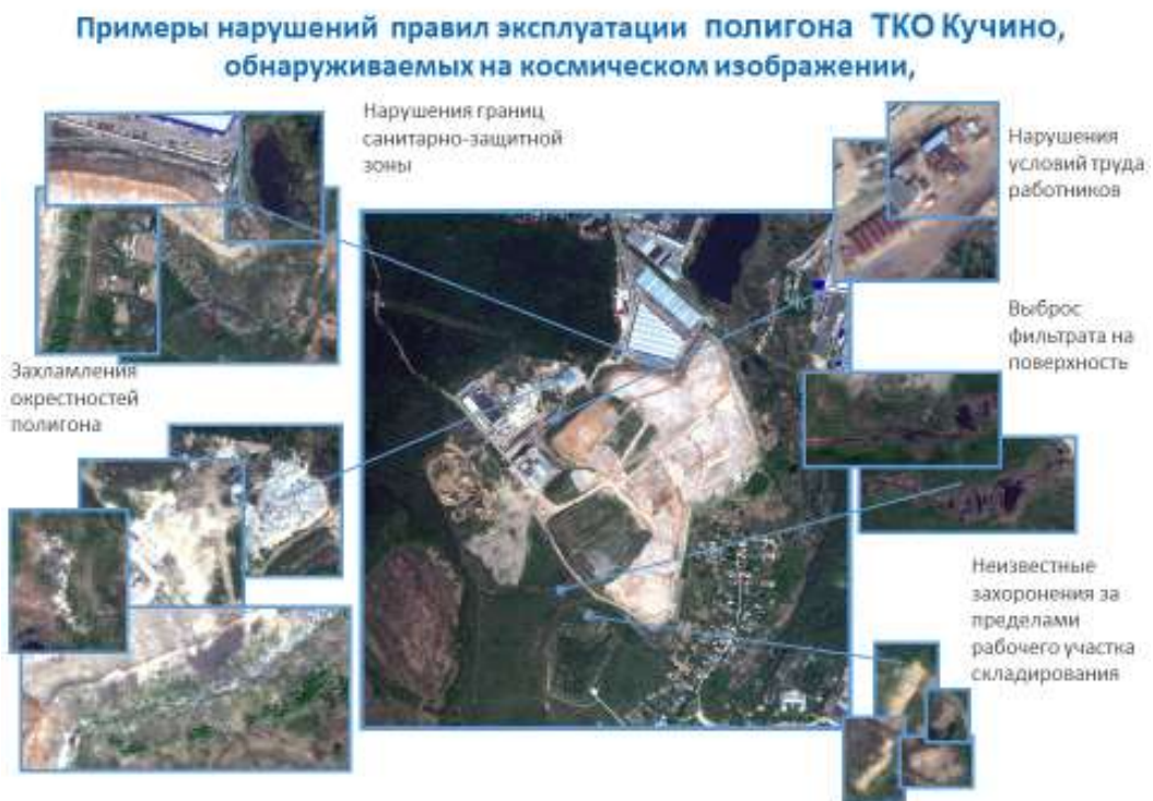
Рис. 3 – Нарушения правил эксплуатации полигона ТКО, выявленные по данным космического мониторинга
